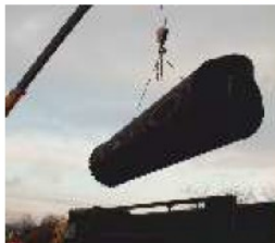
2. OPUSZCZANIE ZBIORNIKA DO WYKOPU
