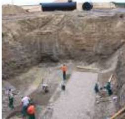
1. PRZYGOTOWANIE PODBUDOWY (FUNDAMENTU KRUSZYWOWEGO)
