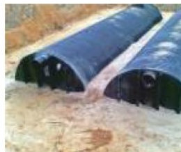
4. UKŁADANIE I ZAGĘSZCZANIE KOLEJNYCH WARSTW ZASYPKI ZBIORNIK
